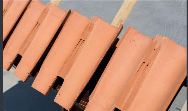
2. Agganciare la prima fila di BICOPPO® al primo listello, adagiandola nella sella della griglia di partenza, che garantirà l'ingresso di aria nel sottomanto bloccando nel contempo insetti e volatili. *Install the first line of BICOPPO® in accordance to the bird-stop on the eave; so air can move on but in the same time insects and birds are stopped*
